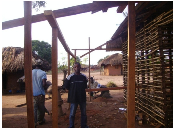
Figura 98: Fase avançada da construção com telha de zinco – sinal de abundância. (2007).
