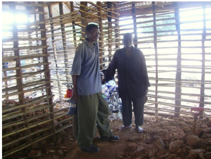
Figura 99: Barro pronto a amassar para cobrir a estrutura de madeira. (2007). Fotos de Ntaluma.
