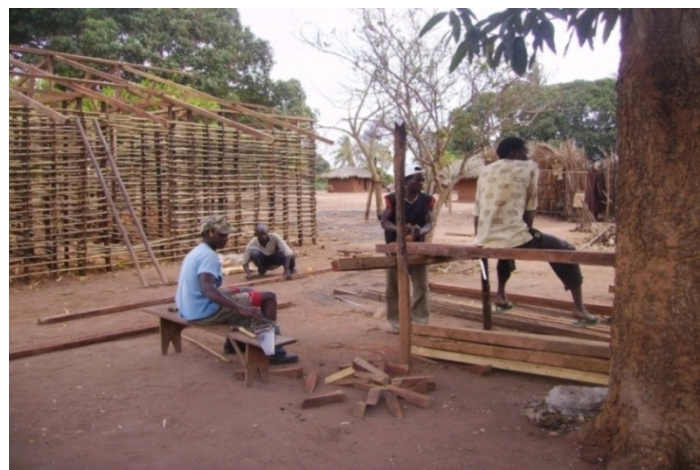
Figura 97: Primeira fase – construção das paredes. Fotos de Ntaluma.
