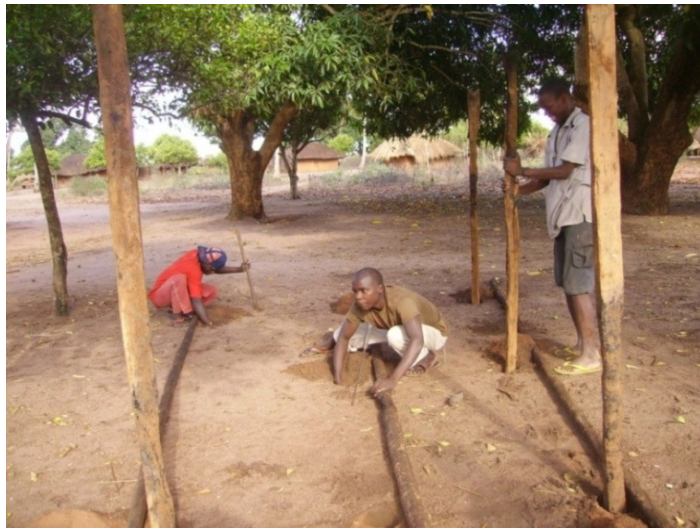
Figura 96: Colocação dos pilares da casa.
